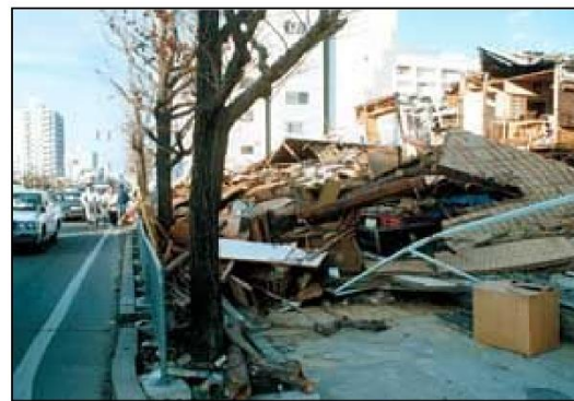
1階部分がわからないほど倒壊した家屋
